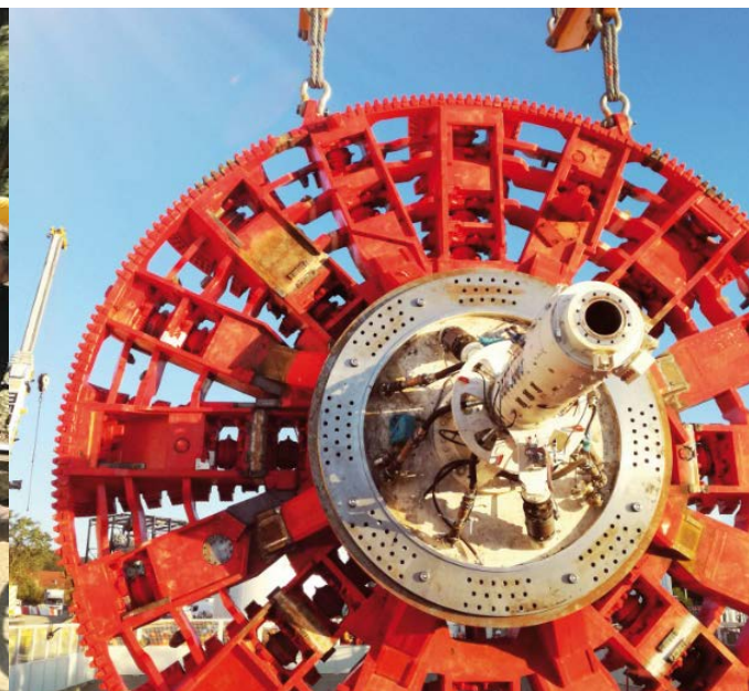
Roue de coupe du tunnelier du métro
